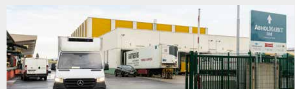
Halban-Kurz-Straße (Ecke Josef-Prangl-Straße) kostenlose Zufahrt zu Fa. Eishken, Fa. Mulackal, Fa. Sabex
